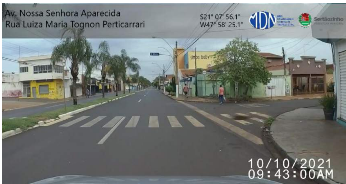
Figura 3. Faixa de Pedestre demarcada fora das normas do CONTRAN. Fonte: Elaborado pelo autor
