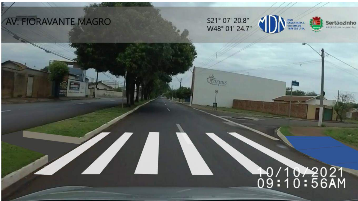
Figura 4. Esquema da proposta de intervenção na Av. Fioravante Magro. Fonte: Elaborado pelo autor.
