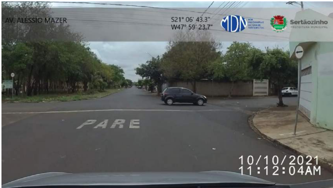
Figura 2. Sinalização horizontal invadindo a via adjacente.
