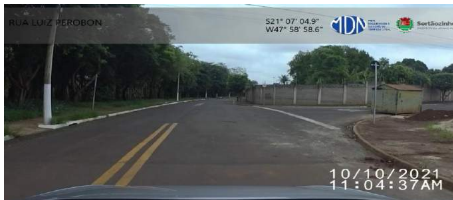
Figura 2 - Rua Luzi Perobon – exemplo – sinalização de aproximação junto às interseções das ruas que chegam na via de análise.
