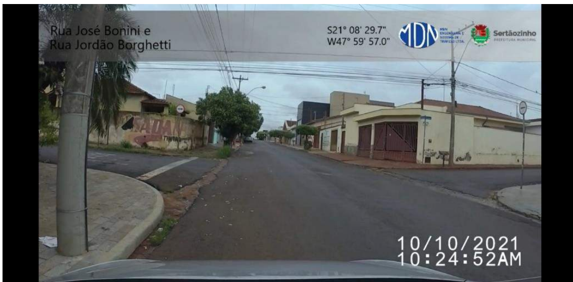
Figura 1 - Sinalização horizontal pouco visível. Fonte: Elaborado pelo autor.
