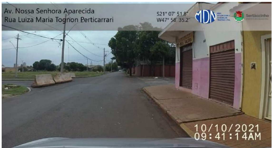
Figura 1. Sinalização horizontal de faixa de pedestres pouco visível. Fonte: Elaborado pelo autor.
