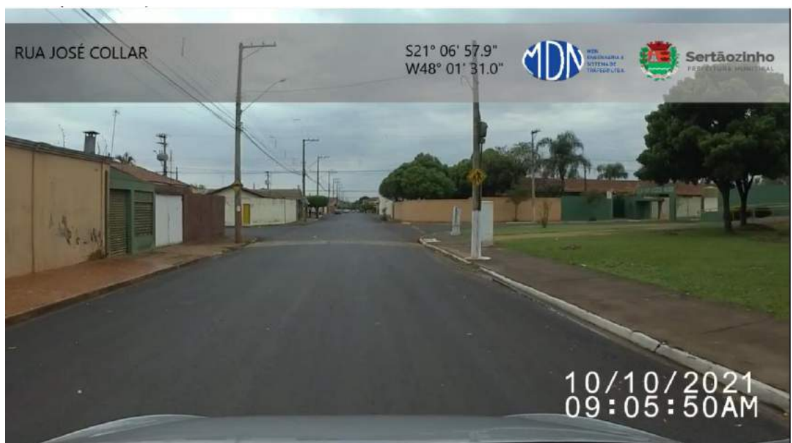
Figura 1. Indicação de faixa de pedestre em situação escolar, mas não há faixa de pedestres. Fonte: Elaborado pelo autor.
