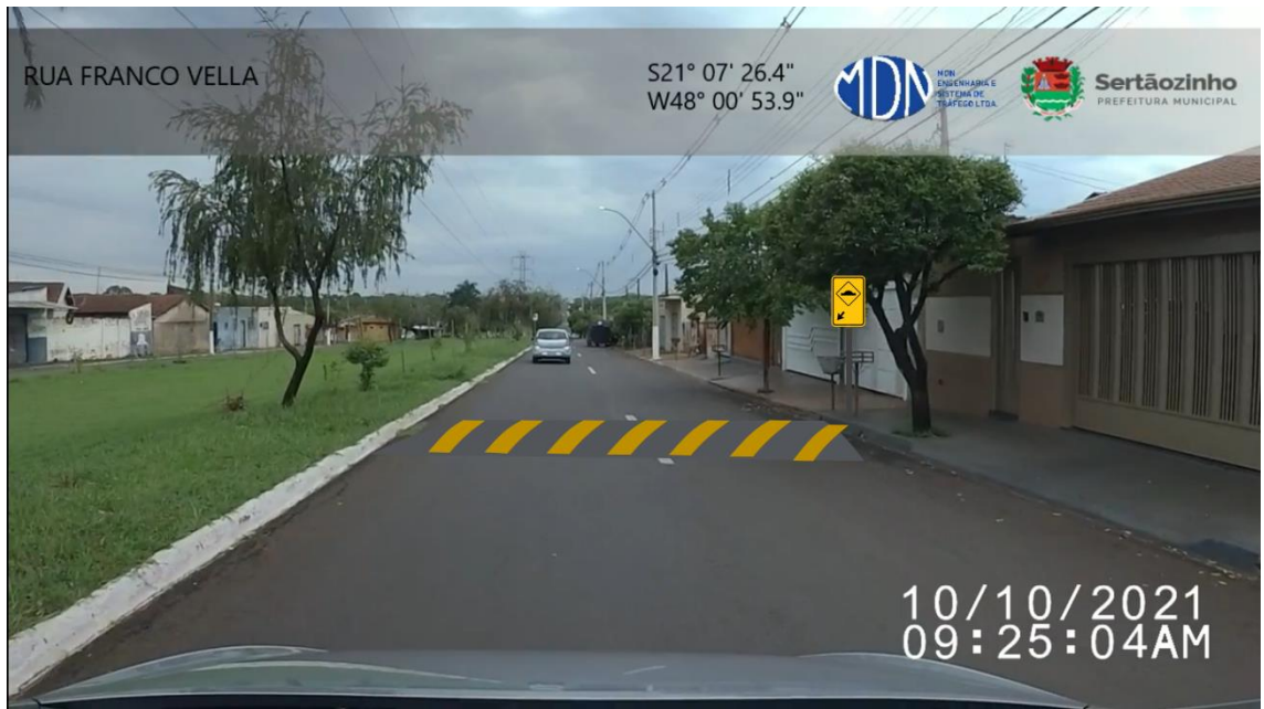
Figura 5. Readequação de posicionamento das lombadas de acordo com as normas do CONTRAN. Fonte: Elaborado pelo autor.
