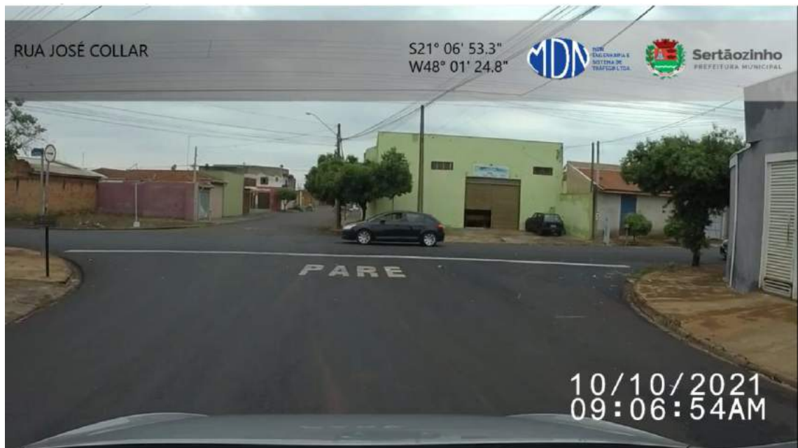
Figura 3. Pares e linhas de retenção muito próximas ao cruzamento. Fonte: Elaborado pelo autor.
