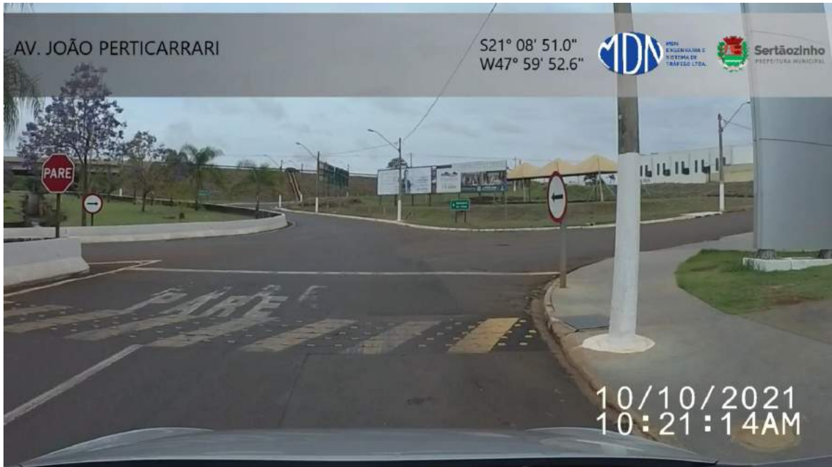
Figura 2. Lombada na Av João Peticarrari próximo a rotatória. Fonte: Elaborado pelo autor.
